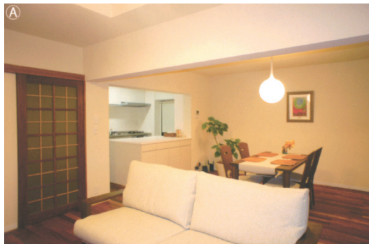
④…広々としたワンルーム空間を創出するため、食堂と和室間にあった壁を取り払った。コンクリート梁は目立たないように内法を揃えている。
