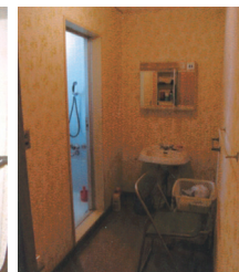
⑤改修前/洗面室
