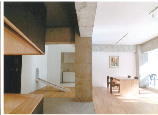
⑫RC柱梁が明るさに濃淡をつくり、室内を緩やかに分節する
