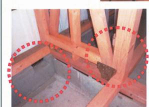
補強基礎と補強金物
