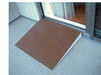
【バルコニー出入り口スロープ】
