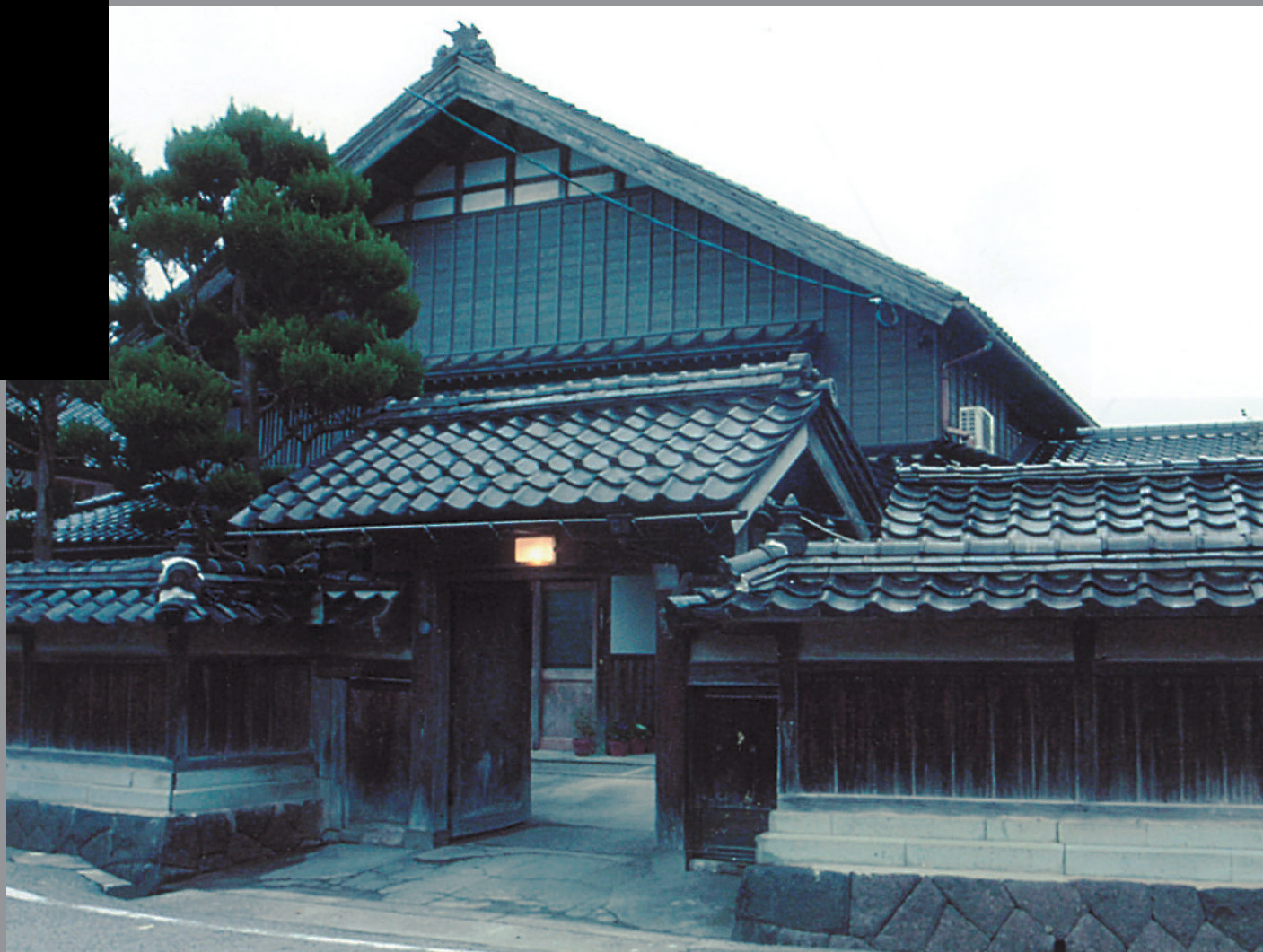
外壁の修復後
