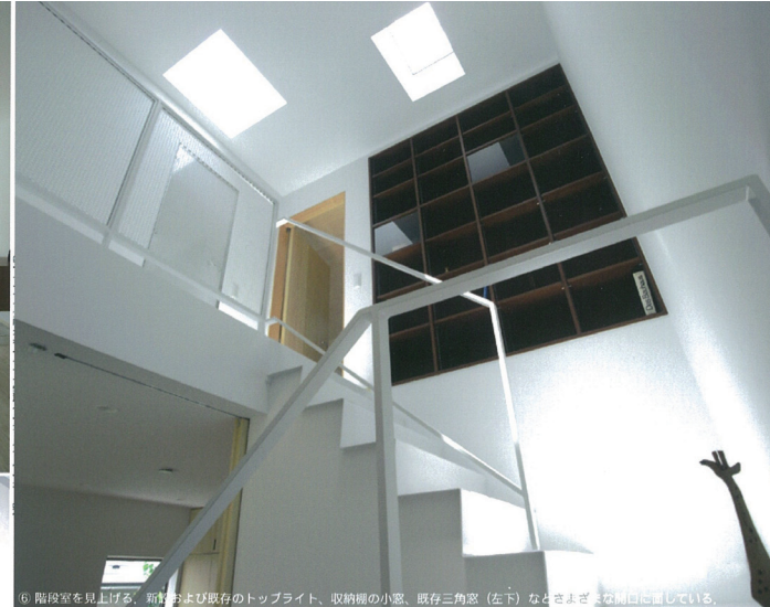
⑨ 階段室を見上げる。新設および既存のトップライト、収納棚の小窓、既存三角窓（左下）などさまざまな開口に重畳している。
