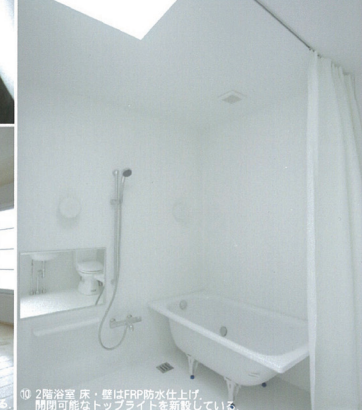
⑬ 2階浴室。床・壁はFRP防水仕上げ、開閉可能なトップライトを新設している。
