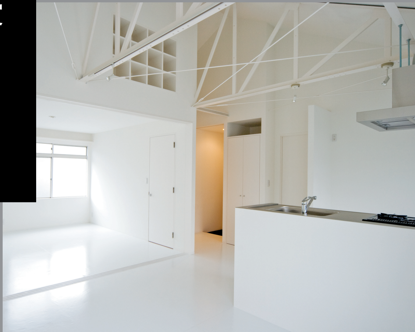
1 改修後:天井を取り払い、軽量鉄骨を室内空間に取り込んだリビング
