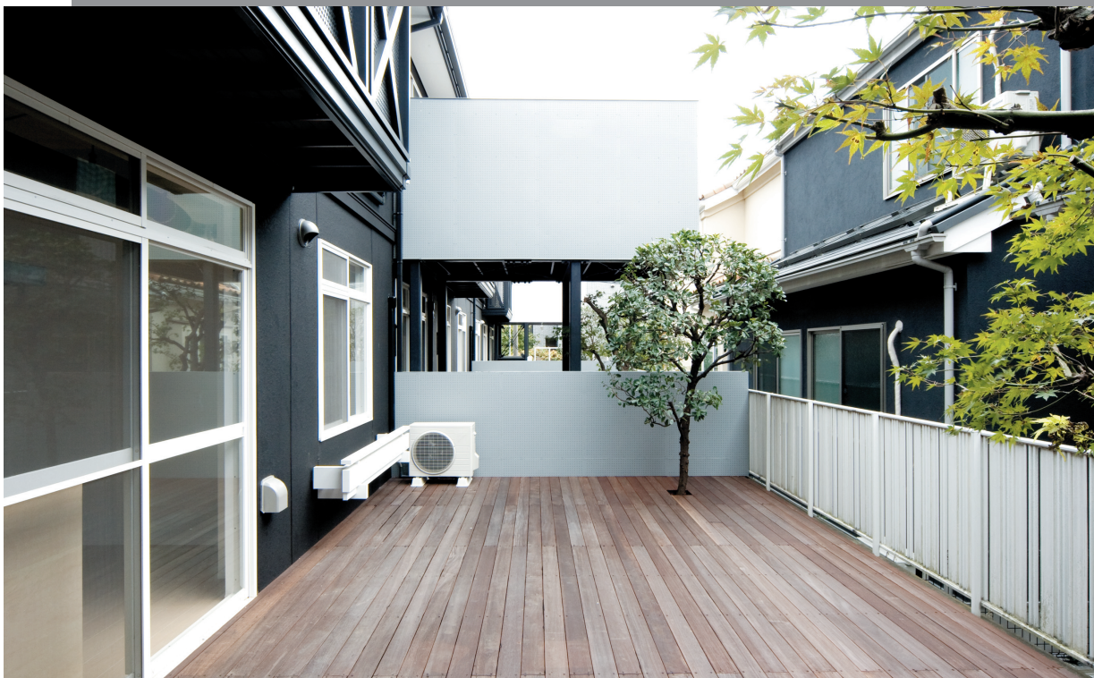
2 改修後：窓先空地を北側通路側に移動する変更を行い、1階に自由テラス、2階に縦長バルコニーを設置
