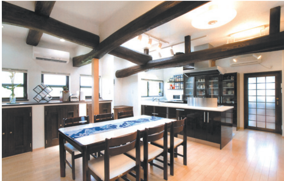
4 天井に隠れていた梁を出し、キッチン建具は色を梁に合わせた。
