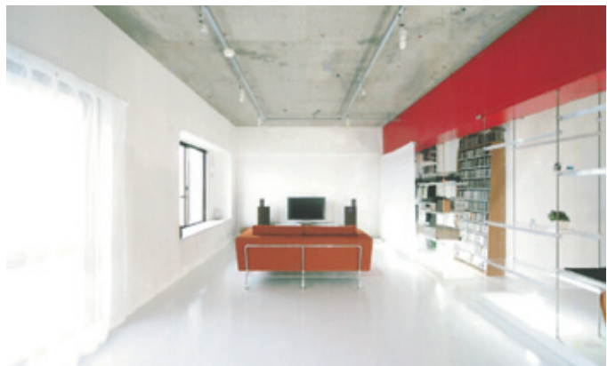
③リビングを見る。白を基調としたシンプルな空間。天井もなくしRC表しとし、配管もむき出しにしている。これにより天井高は2.6mと高めになり、ワンルームとしても大空間がいっそう広く感じられる。
