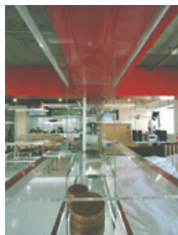
⑥梁にと収納。収納部分にはカーテンレールが取り付けられており、場合によっては個室としての利用も可能。
