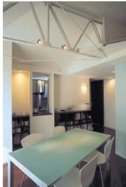
④プレハブ構造の躯体をあらわして天井を高くし、間仕切りにはガラスモザイクタイルを張ったR壁を配して、起伏に富んだ豊かな空間を演出。
