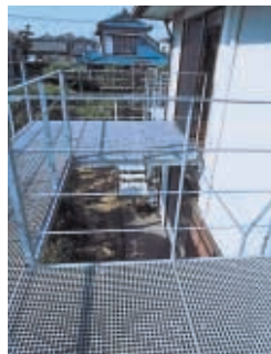
②ファイバークレーチングのバルコニーは、1階へ光と風を届ける。
