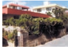
①閉鎖的で暑苦しい外観
