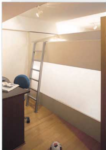
③ 床面積を補い上部空間を活かすため2段ベッドを造作。2人が両側から互い違いに使用できるようになっている。
