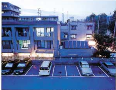
③ 南側外観とソーラーパネル
