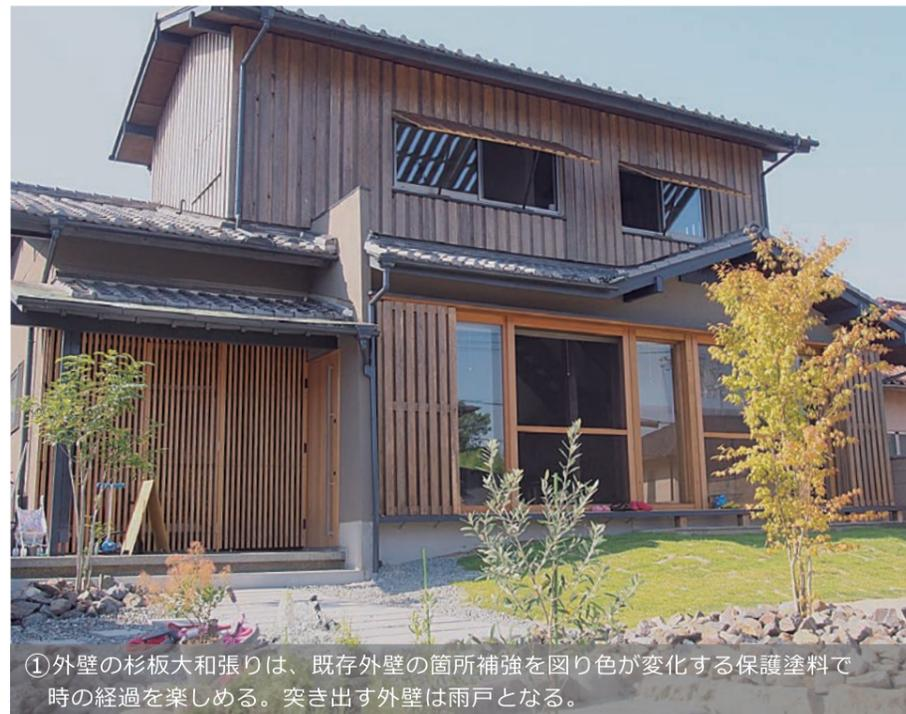
①外壁の杉板大和張り、既存外壁の箇所補強を図り色が変化する保護塗料で時の経過を楽しめる。突き出す外壁は雨戸となる。
